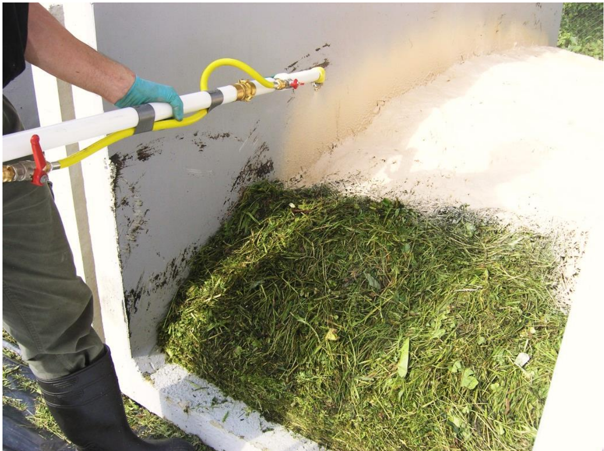
Abbildung 2: Abdecken einer Versuchssiloanlage mit einer spritzbaren Zweikomponentenmischung auf Basis Nachwachsender Rohstoffe
