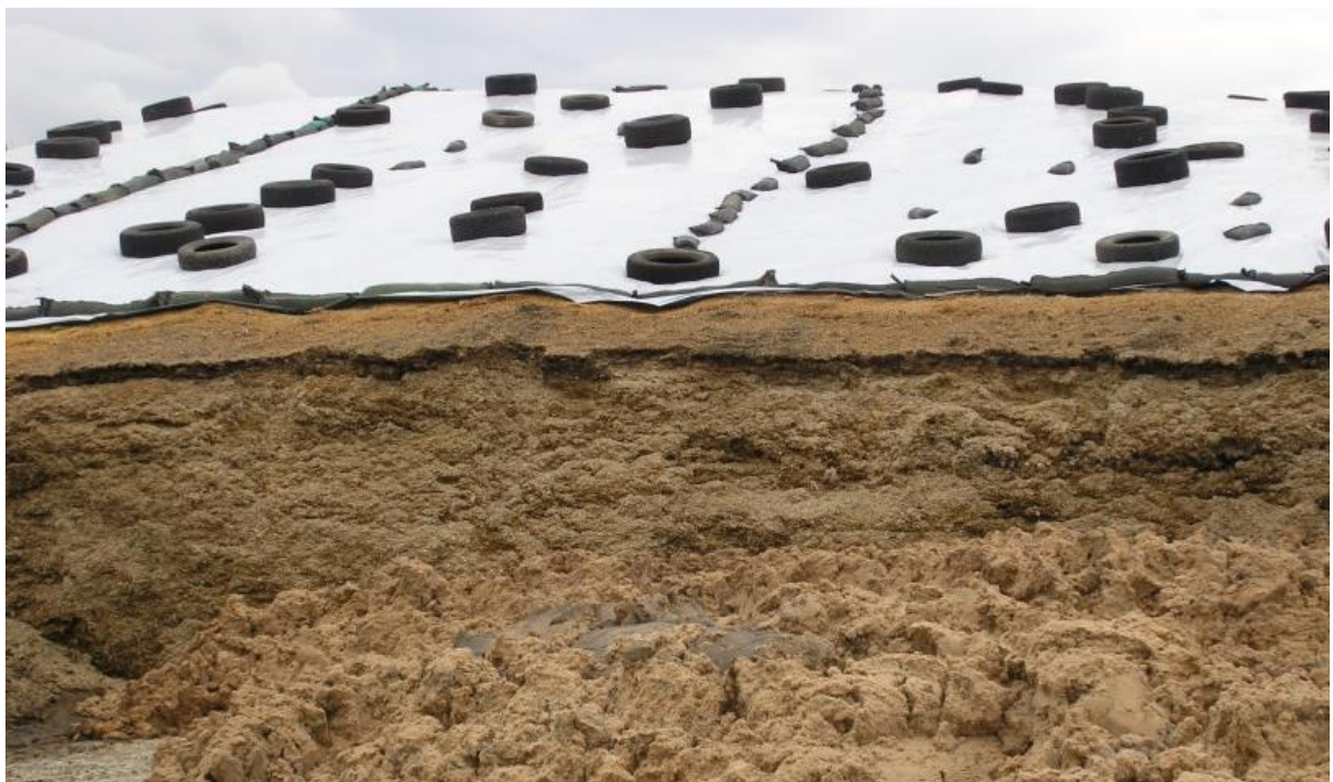
Abbildung 1: Abdeckung einer Siloanlage
