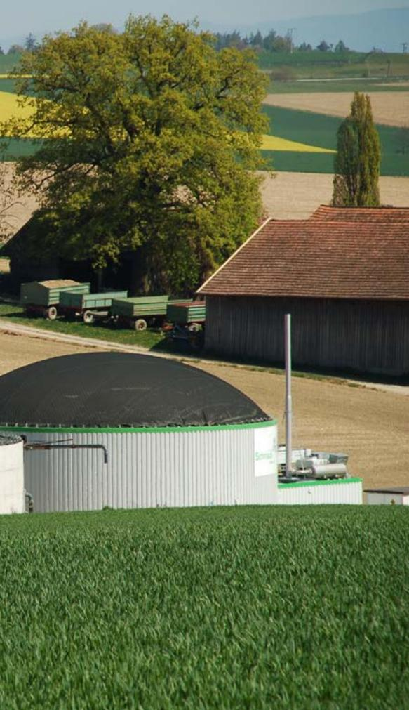
In Biogasanlagen werden organische Stoffe unter Luftsabschluss vergoren. Als gasförmiges Endprodukt dieses Gärprozesses entsteht Methan, aus dem in einem Blockheizkraftwerk (BHKW) Strom und Wärme gewonnen werden. Es ist auch möglich, das Biogas aufzureinigen und in das Erdgasnetz einzuspeisen. Dieses „Bio-Erdgas“ kann flexibler und auch als Kraftstoff genutzt werden.
