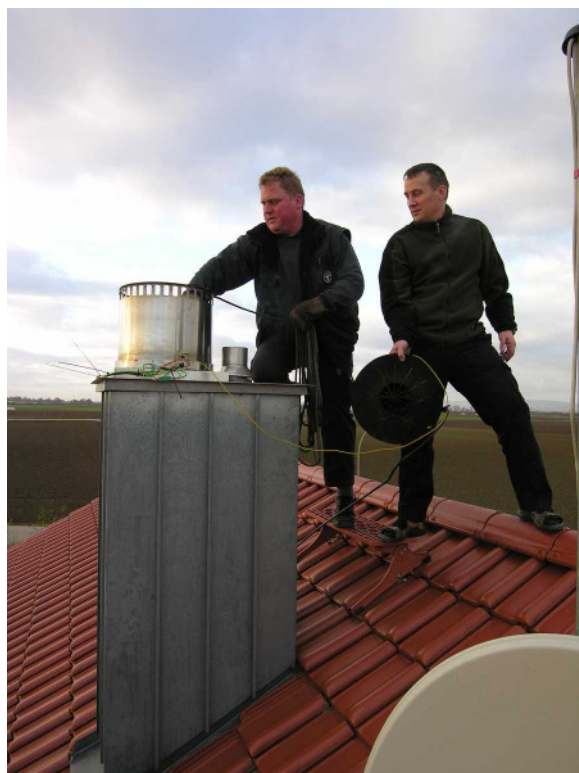
Abbildung: Der zuständige Kaminkehrer Markus Eckl (links) und Arild Nesse von der Firma APP aus Norwegen (rechts) bei der Inbetriebnahme eines an einem Schornstein aufgebauten Staubabscheiders zu Beginn des Feldversuchs
