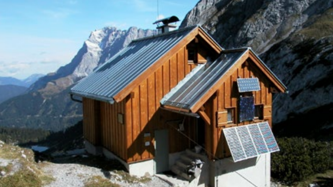
Materialsseilbahn Bergstation und BHKW-Aufstellraum der Coburger Hütte
