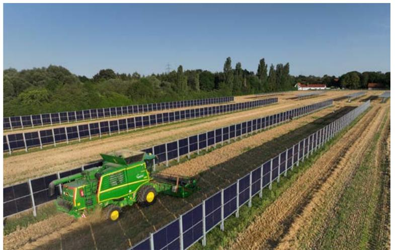
Vertikale Agri-PV-Anlage mit bifazialen Modulen bei der Ernte in Grub
