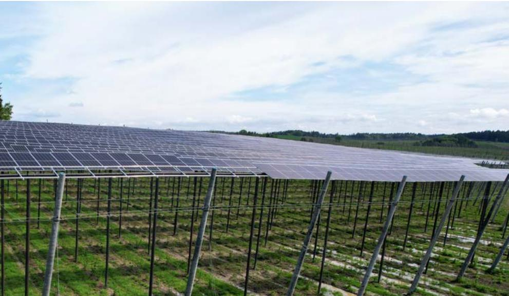
Hoch aufgeständerte Agri-PV-Anlage über Hopfen in Au in der Hallertau
