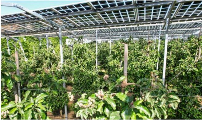
Hoch aufgeständerte Agri-PV-Anlage über Äpfeln in Kressbronn
