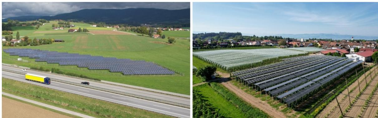
Abbildung 38: Vergleich zwischen PV-FFA (links) und hoch aufgeständerter Agri-PV-Anlage (rechts)
