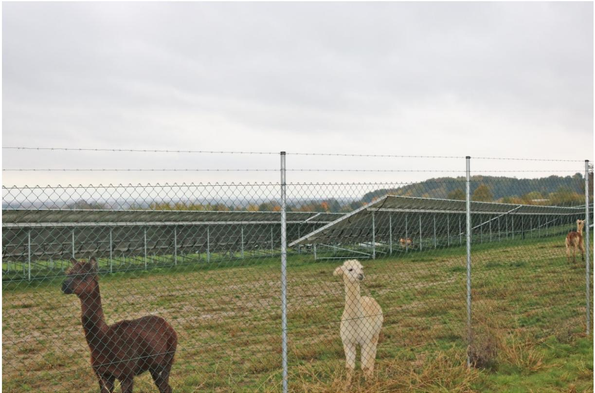
*Abbildung 11: Beispiel für einen Maschendrahtzaun mit Übersteigschutz*
