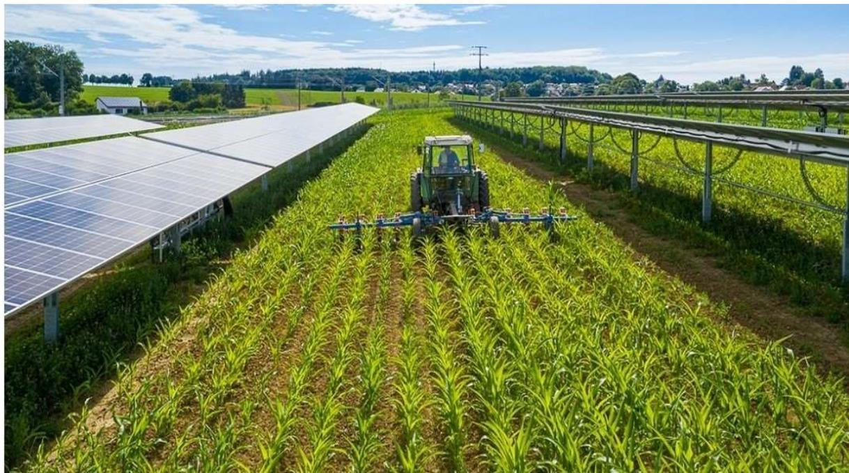
*Abbildung 36: Nachgeführte Agri-PV-Anlage in Althegnenberg*
