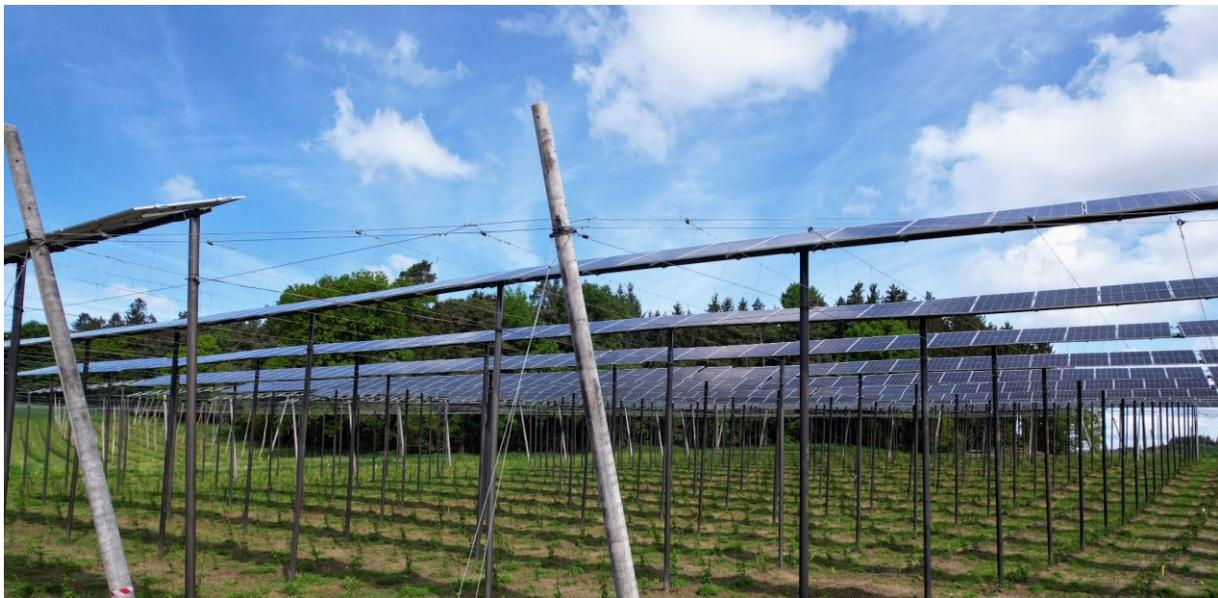
Abbildung 1: Hoch aufgeständerte Agri-PV-Anlage über Hopfen in Au in der Hallertau
