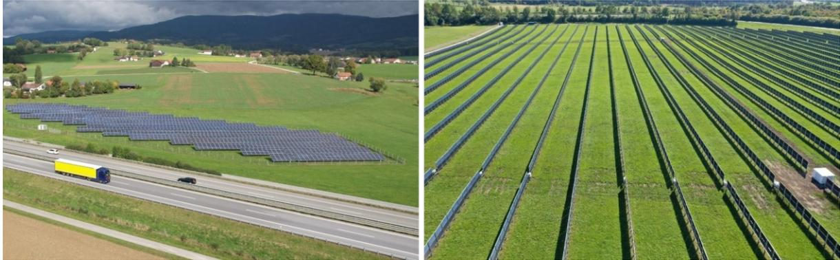
Abbildung 37: Vergleich zwischen PV-Freiflächenanlage (links) und vertikaler Agri-PV-Anlage (rechts)
