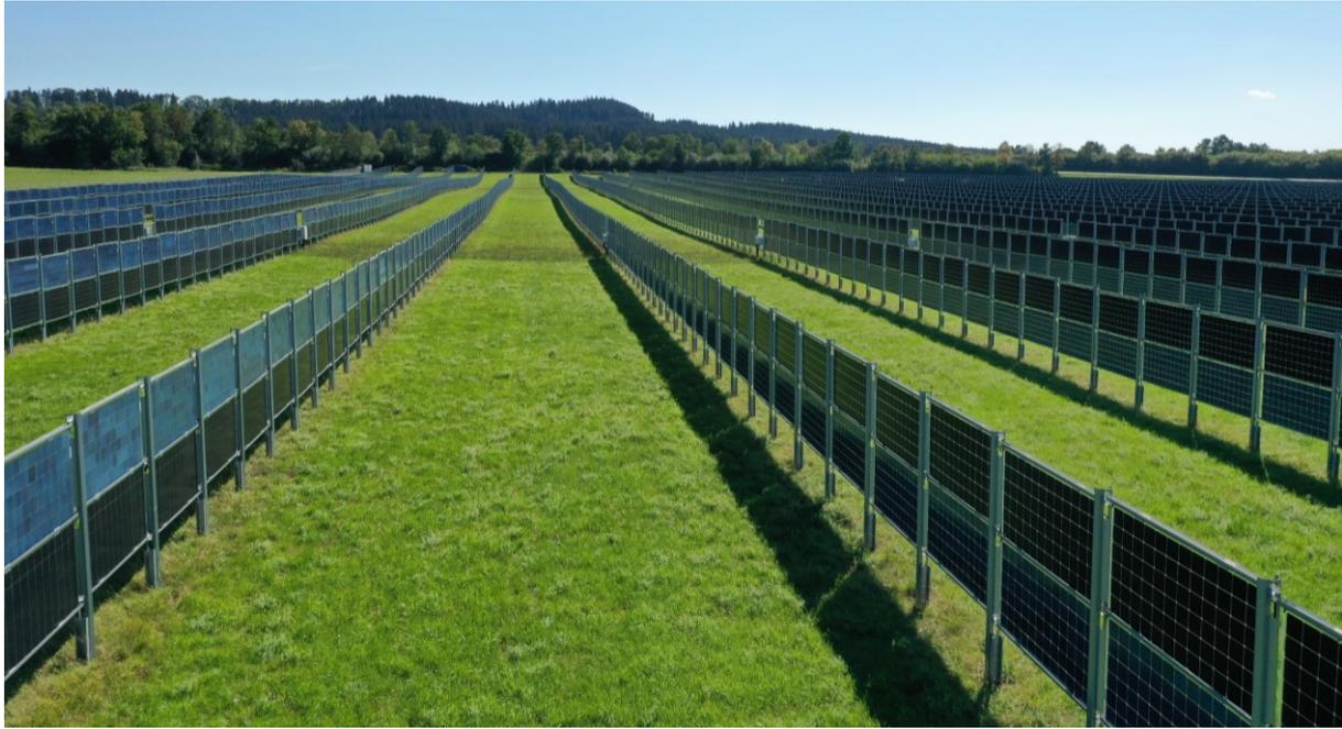
*Abbildung 3: Vertikale Agri-PV-Anlage auf extensivem Dauergrünland in Donaueschingen*
