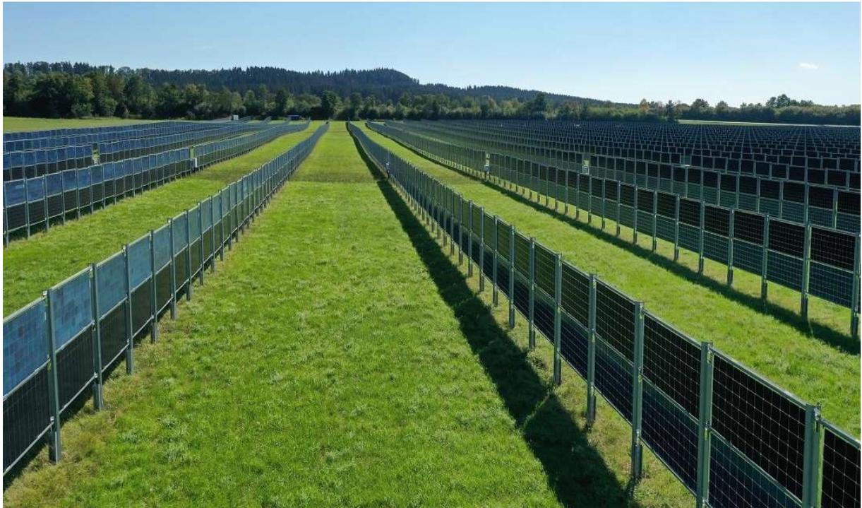
*Abbildung 33: Vertikale Agri-PV-Anlage auf extensivem Dauergrünland*
