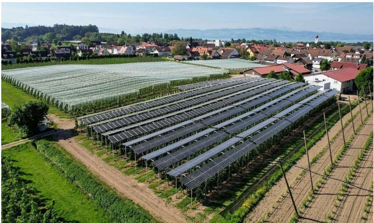
*Abbildung 34: Hoch aufgeständerte Agri-PV-Anlage über Äpfeln in Kressbronn*
