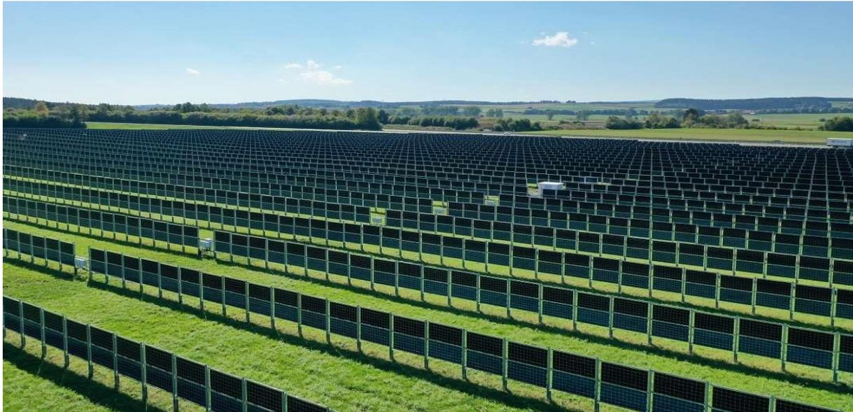
*Abbildung 32: Vertikale Agri-PV-Anlage auf extensivem Dauergrünland*
