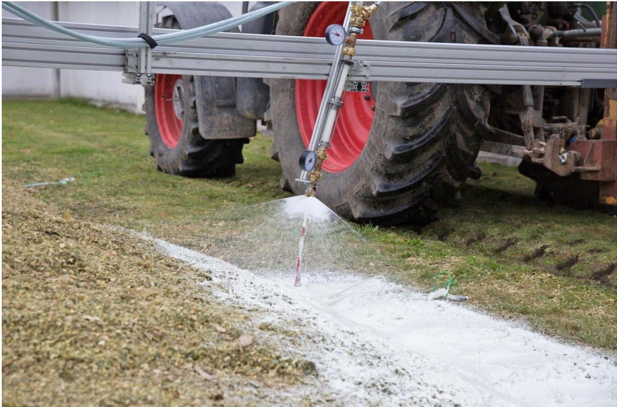
Abbildung 1: Praxistest der aufspritzbaren Silageabdeckung
