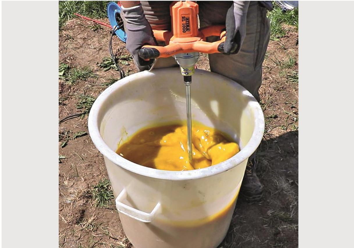
Abbildung 41: Anmischen der ölhaltigen Komponente mit einem Handrührgerät
