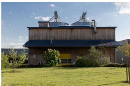
Dezentrale Ölmühle: Hier kann Rapssaar zu Rapsölkraftstoff und Rapspresskuchen verarbeitet werden
