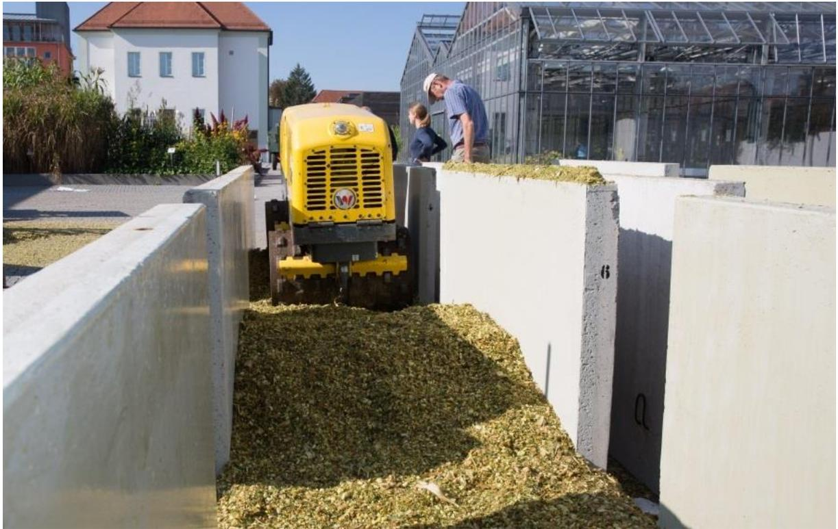
Abbildung 21: Verdichten der Miniaturesilos mit einer Grabenwalze
