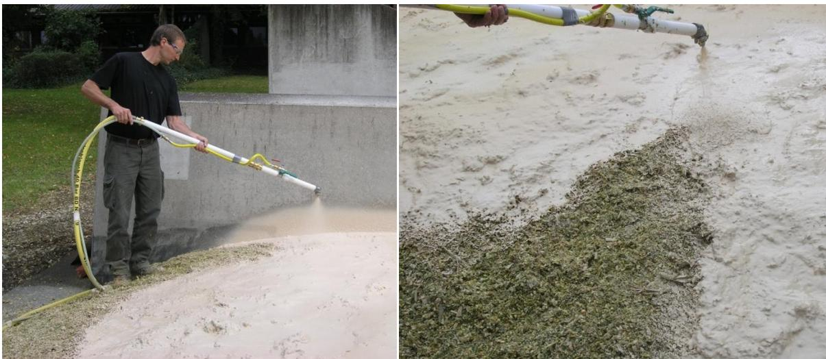
Abbildung 28: Auftragen von Abdeckmaterial mit dem Feinputzspritzgerät
