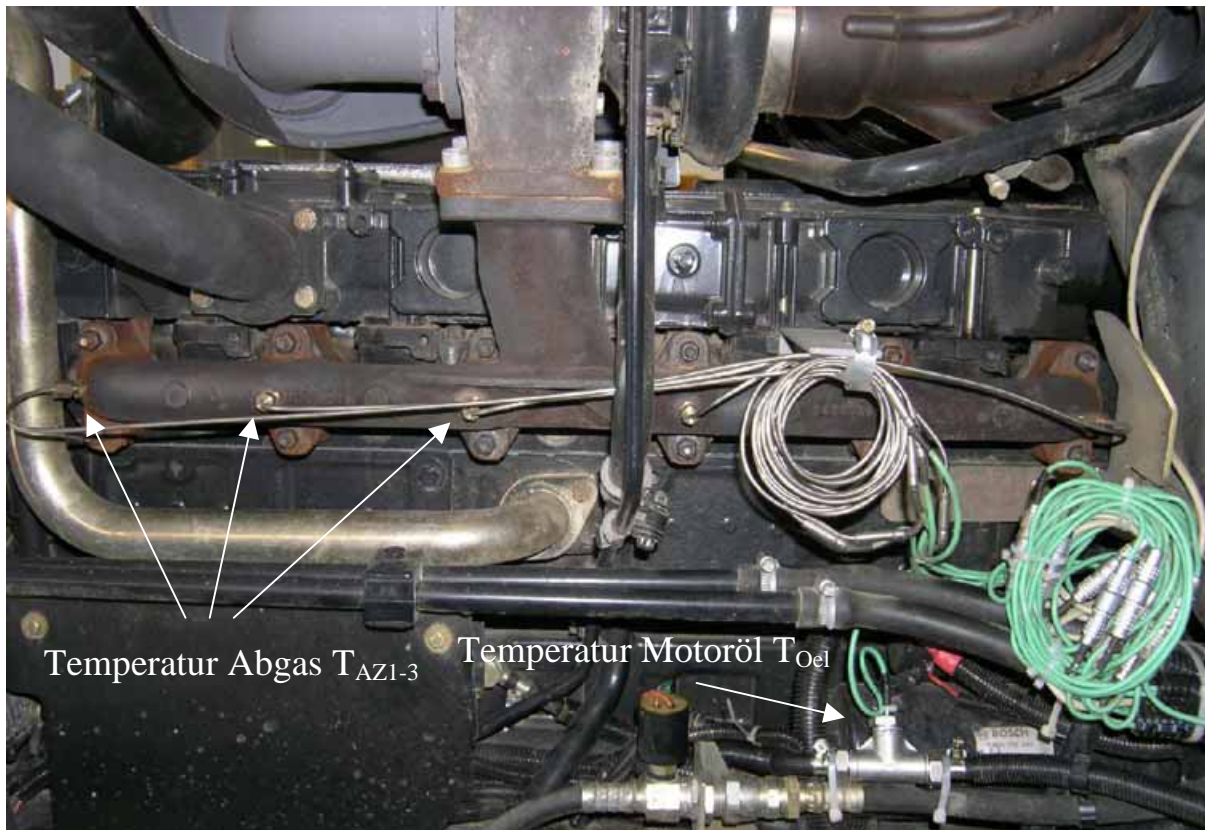
Abbildung 2: Einbauposition der Abgastemperatursensoren und des Motoröltemperatursensors an einem Deutz-Fahr Agrotion TTV 1160
