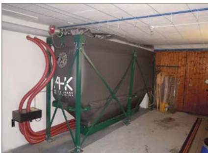
Abb. 10b: Trog silo mit mehreren Saugentnahmepunkten
