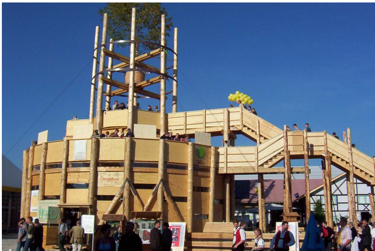
Abbildung 36: Der Energieturm war der Blickfang des Zentral-Landwirtschaftsfestes
