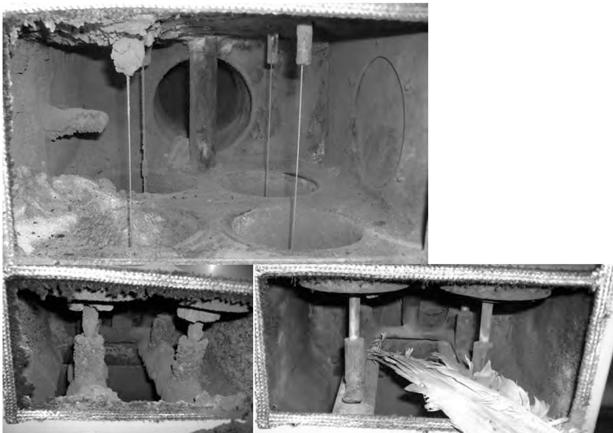
Abbildung 37: Bild oben: Obere Öffnungsklappe des SFF20, linke Seite mit Ascheablagerungen, rechte Seite gereinigt. Bilder unten: untere Öffnungsklappe des SFF20 mit Ascheablagerungen (links: ungereinigt; rechts: gereinigt)
