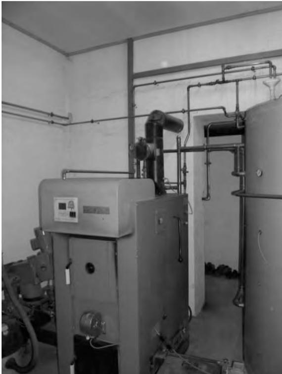
Abbildung 27: Hackschnitzelkessel
