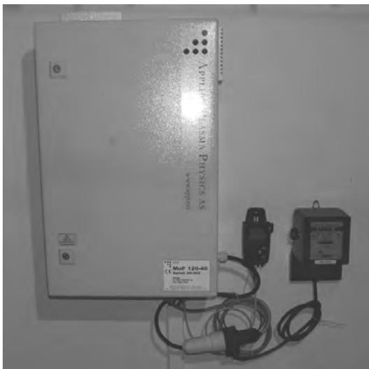
Abbildung 21: Schaltkasten des APP Residential ESP
