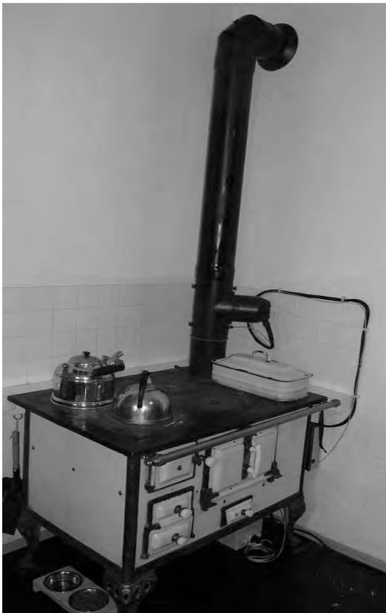
Abbildung 12: KW Zumikron nach einem Küchenherd
