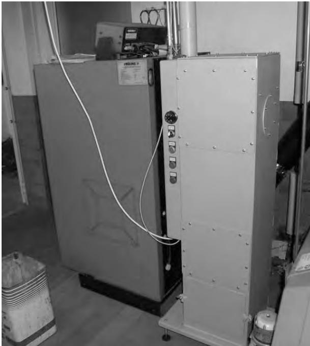
*Abbildung 23: Scheitholzessel mit nachgeschaltetem SFF20*
