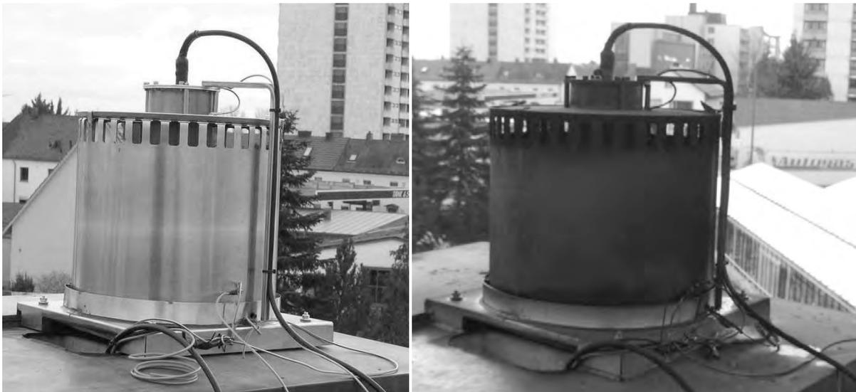
Abbildung 35: APP Residential ESP nach dem Einbau (links) und in Betrieb (rechts)
