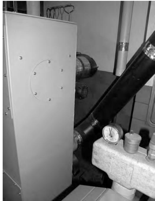
*Abbildung 24: Rauchrohr-Anschlüsse des SFF20*
