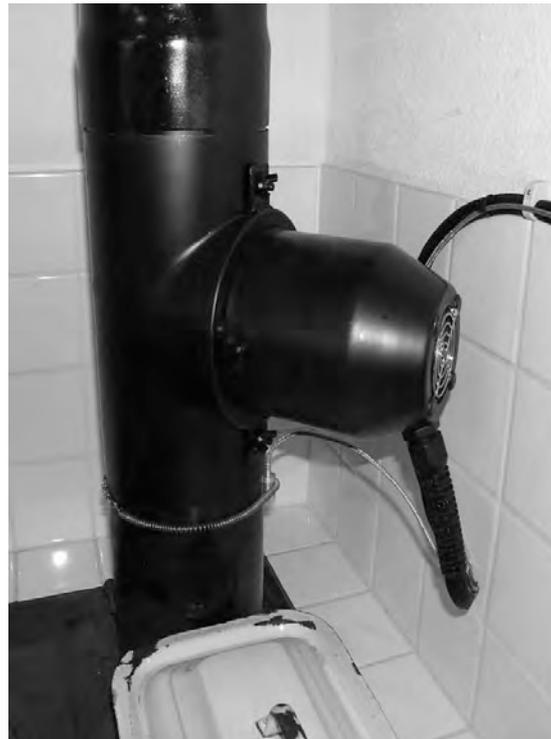
Abbildung 13: KW Zumikron im Rauchrohr
