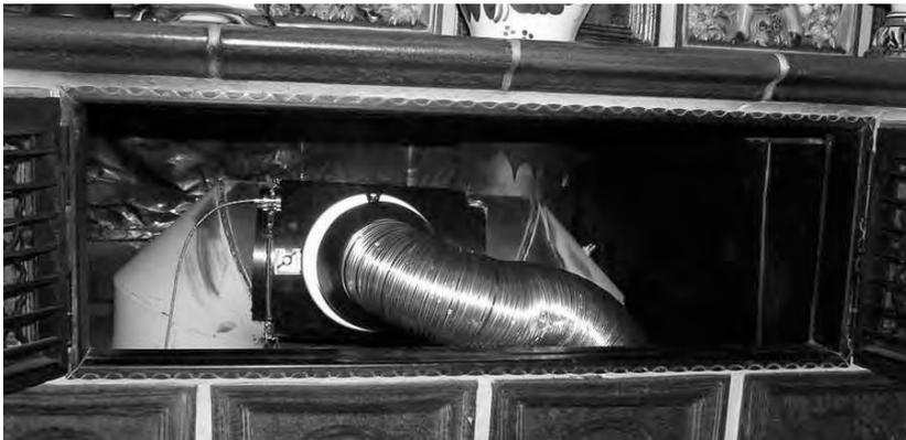
Abbildung 9: KW Zumikron im Rauchrohr vor dem Nachheizkasten
