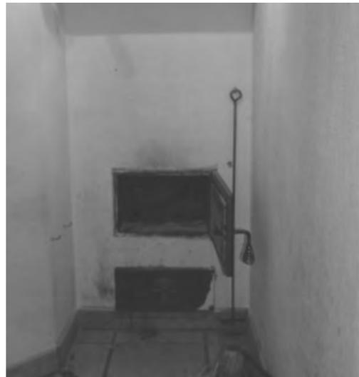
Abbildung 20: Tür zur Befüllung des Grundofens
