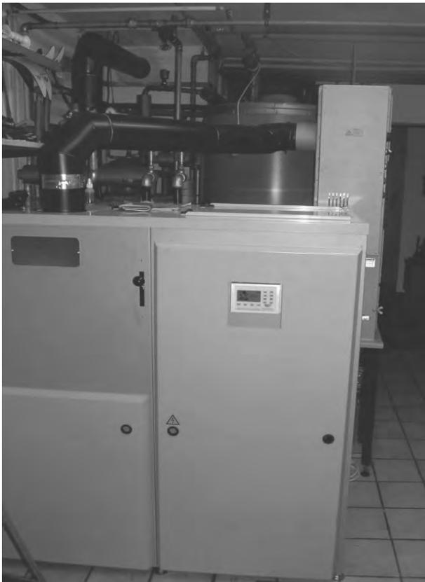
Abbildung 25: Pelletkessel mit nachgeschaltetem SFF20
